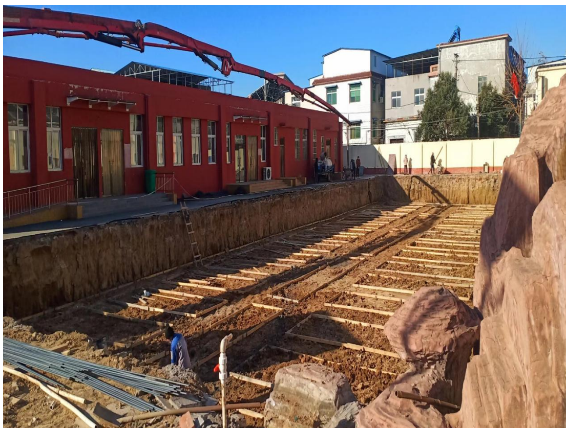
新建宿舍楼地基开挖
